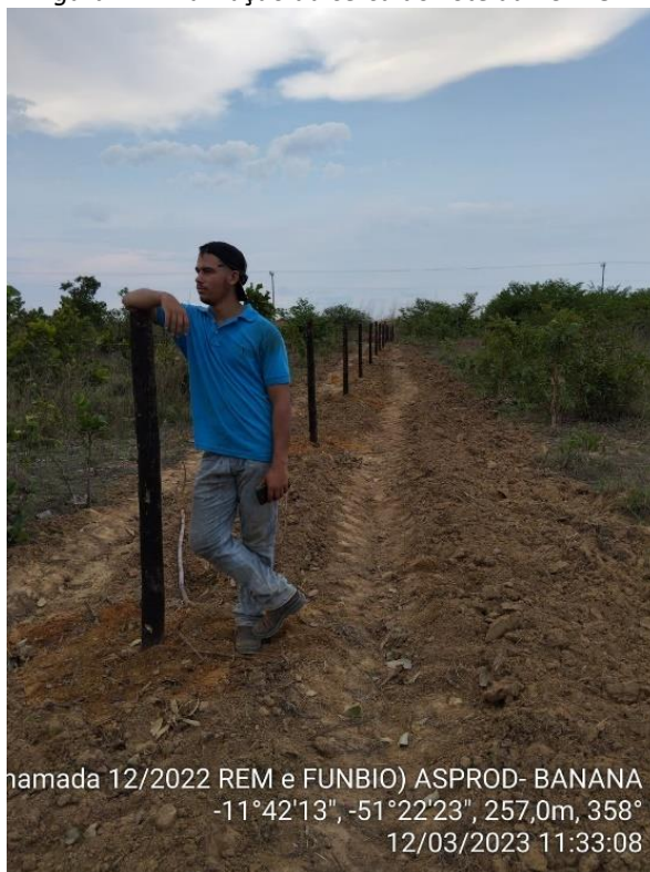
Figura 2 - Início da perfuração do poço artesiano no lote da Associação Asprod onde vai implantar o poço Artesiano para a captação de água para irrigação para os produtores do Assentamento Casulo Vida Nova Alto Boa Vista MT
