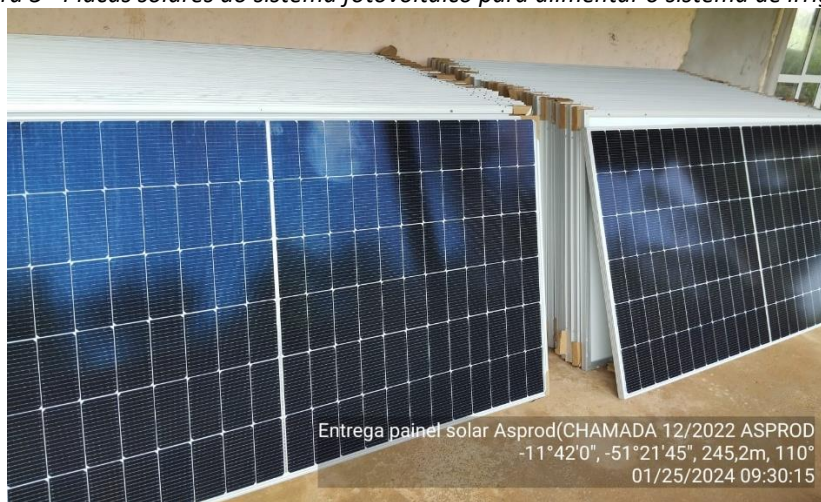
Figura 5 - Placas solares do sistema fotovoltaico para alimentar o sistema de irrigação
