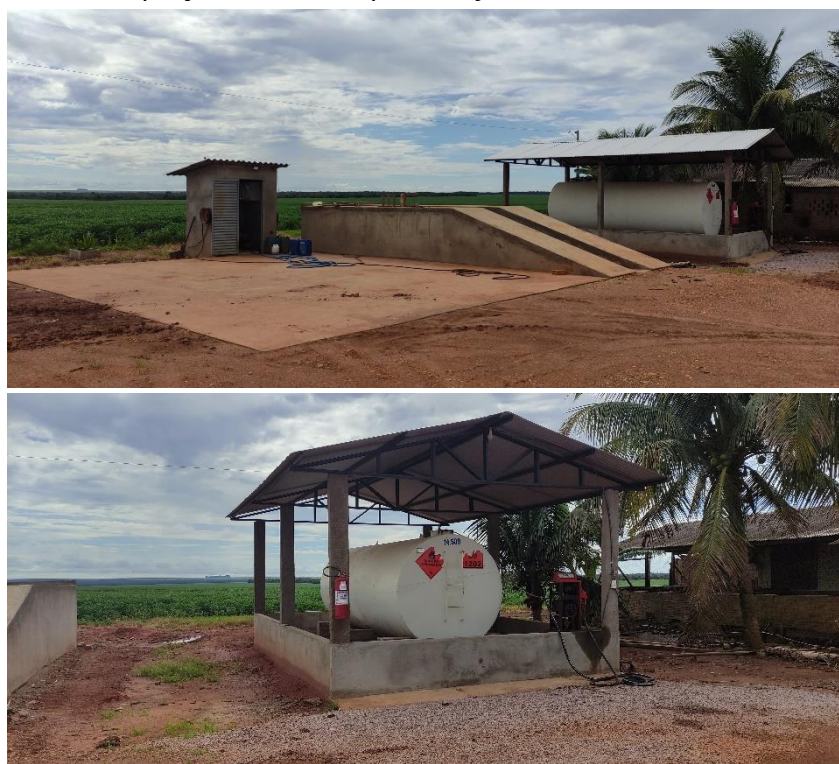
Acompanhamento de adequação realizada: construção da área de armazenamento de combustível e lava jato na propriedade.
