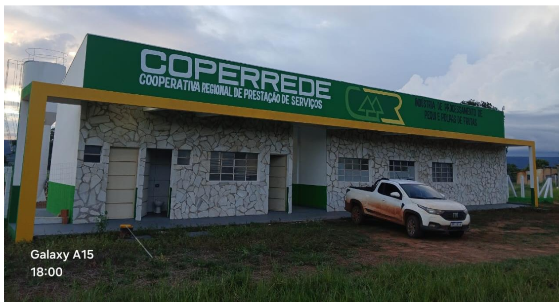
Figura 11: Foto da fachada do prédio concluída
