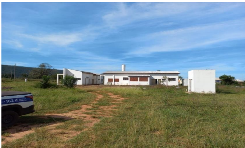
Figura 21: Foto da Identificação do local para a instalação da agroindústria em Alto Paraguai/ MT (06/11/2023).
