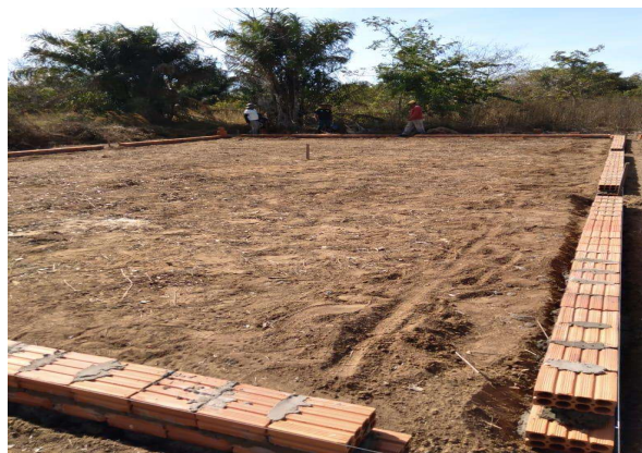
Fig. Início da fundação do Barracão Beneficiadora de arroz
