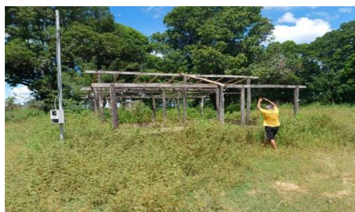
Fig. Estrutura de galinheiro em construção visita de campo em 13/04/2023
