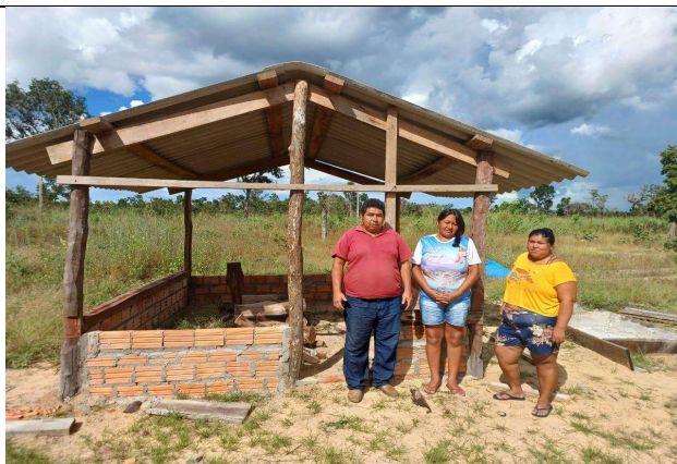
Fig. Estrutura de galinheiro em construção visita de campo em 13/04/2023
