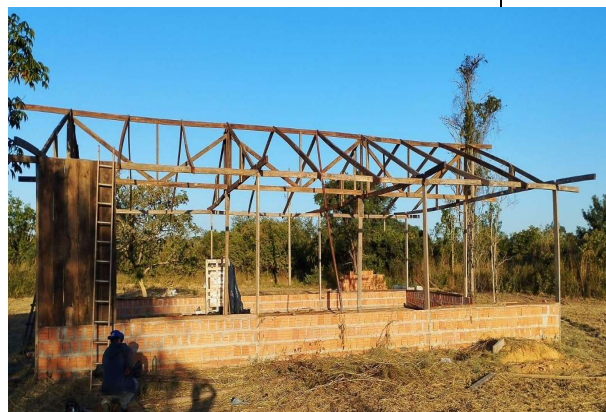
Fig. Construção de Barracão Beneficiadora de arroz
