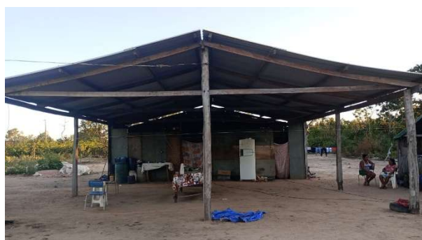
Fig Centro Multiuso Aldeia Galdino Pimentel Reformado em: 12/06/2024
