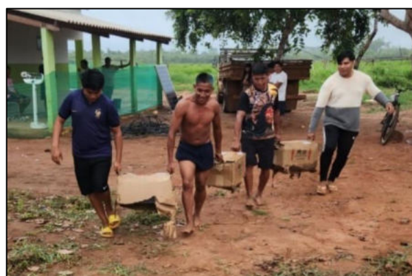
Transporte dos materiais para instalação do sistema de energia fotovoltaica.
