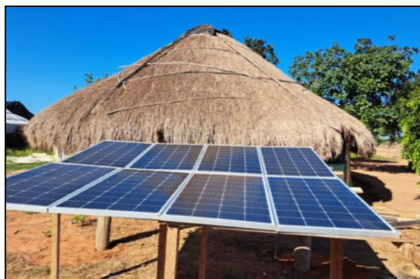
Instalação do sistema fotovoltaico.
