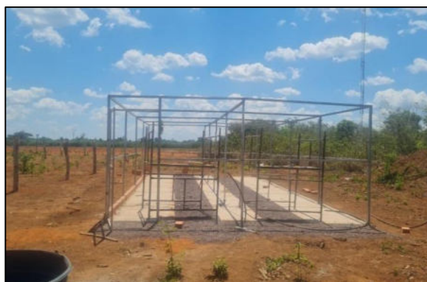
Construção do Viveiro.
