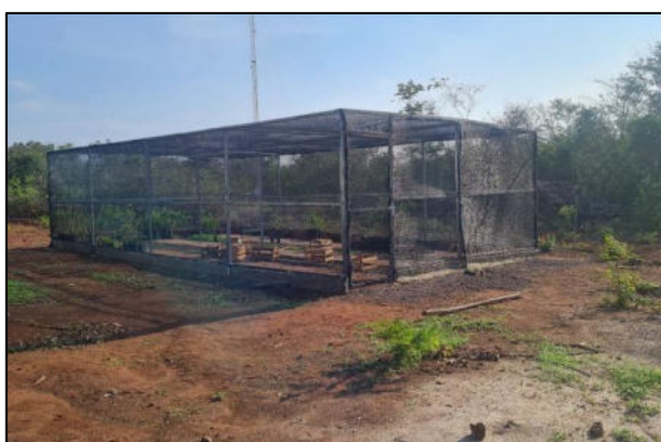
Construção do Viveiro.
