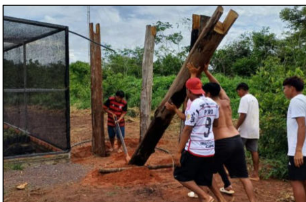
Construção do Viveiro. Instalação da Caixa d'água.
