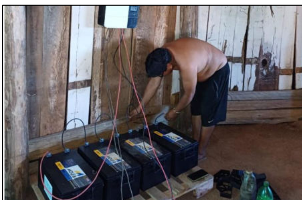
Instalação do sistema fotovoltaico.
