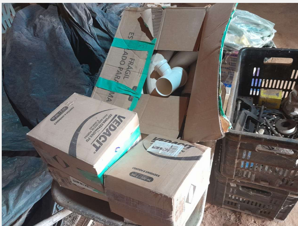
Foto 2: Materiais hidráulicos da mini usina sendo descarregados do Polo Wawi
