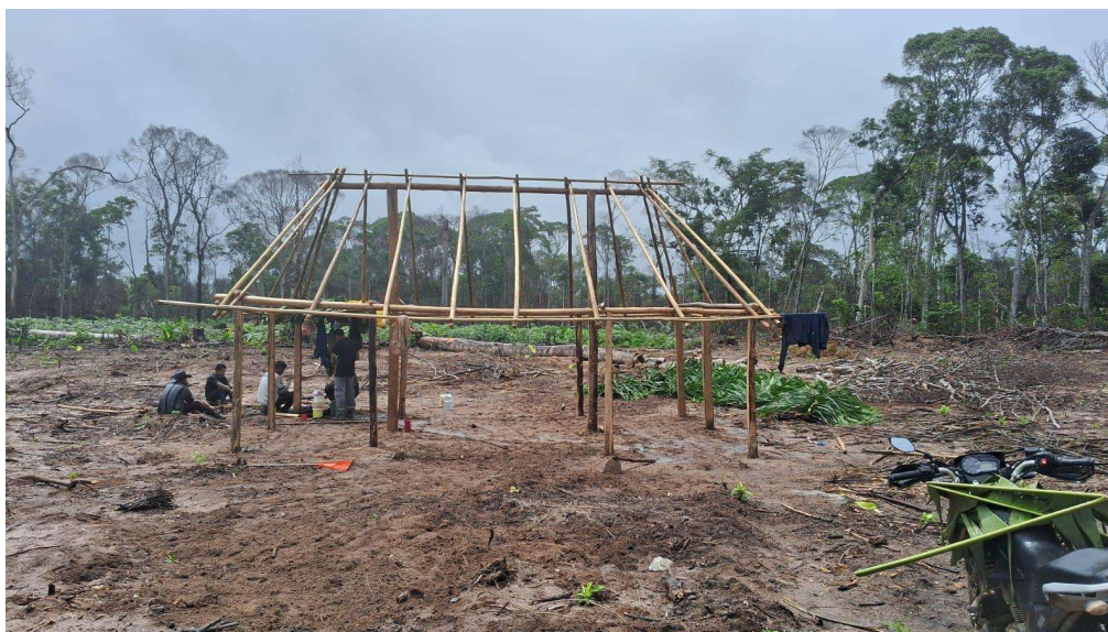
Figura 12. Início da Construção das casas na aldeia Poreby. Fotografia: Krangre Kayapó.
