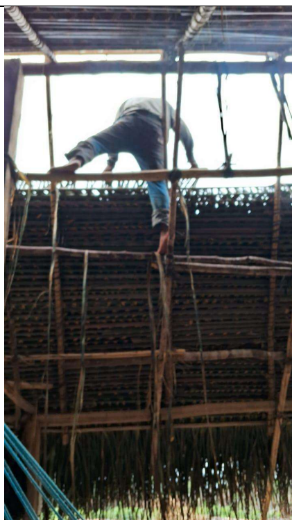
Figura 13. Momento de colocar telhado em uma casa em construção tradicional na aldeia Poreby. Fotografia: Karangre Kayapó.
