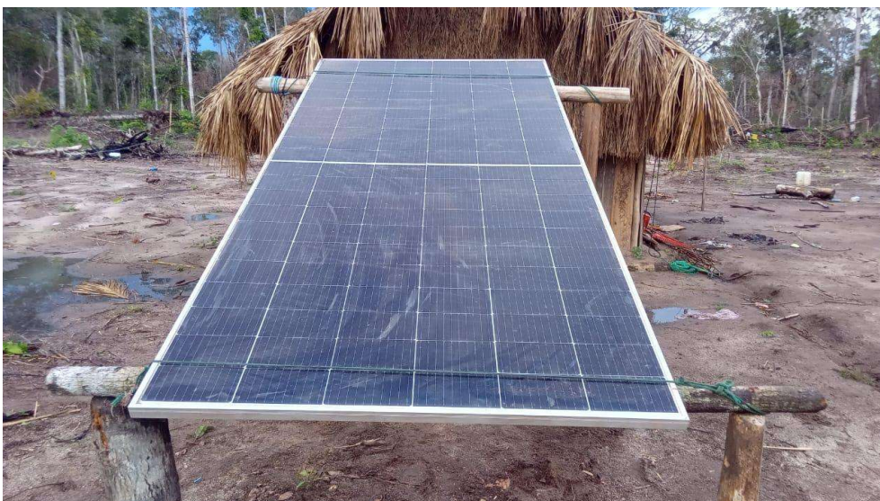
Figura 5. Sistema solar instalado para alimentar a antena da Starlink. Fotografia: Roiti Metuktire.
