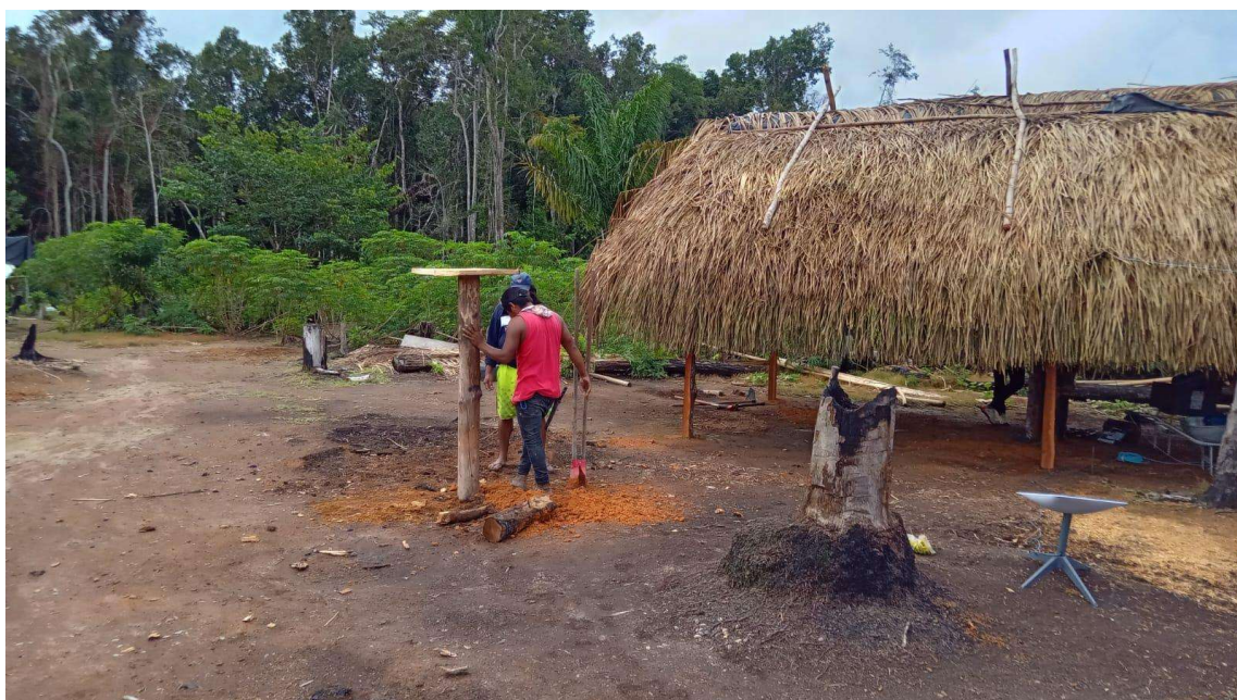
Figura 2. Preparo de estrutura em madeira para fixar a antena da Starlink na aldeia Kadjatnhõrõ. Fotografia: Roiti Metuktire.
