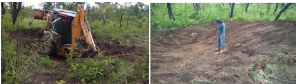
Imagem 37 (esq.) e Imagem 38 (dir): confecção das bacias de captação sobre o trajeto da enxurrada.
