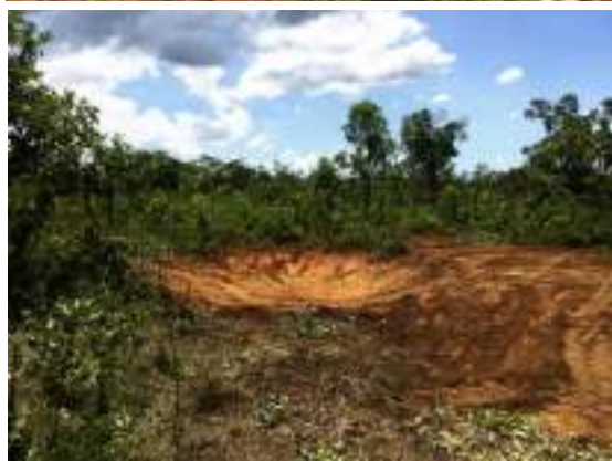
Imagens 40, 41, 42 e 43: Algumas das bacias de captação construídas pelo projeto.
