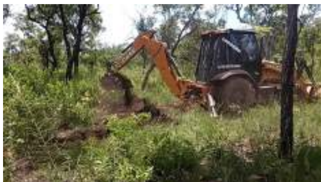
Imagem 45: Construção de bacia de captação
