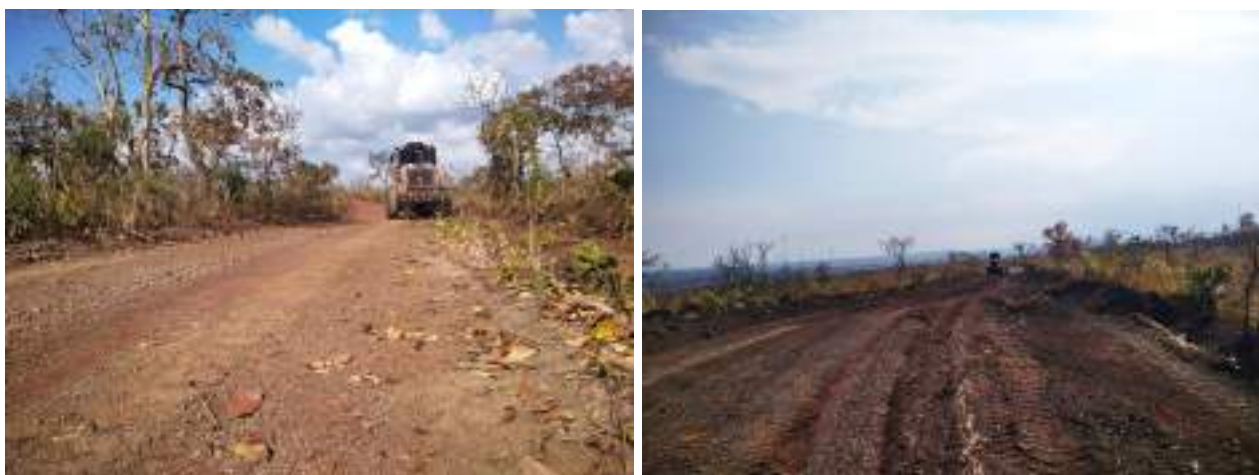
Imagens 11 (esq.) e 12 (dir): Serviço de acabamento, com patrol da prefeitura de Barra do Garças – MT, para alargamento da pista e consequente transformação em aceiro do trecho inicial da estrada de acesso à aldeia São Brás. 30 ago 2023.
