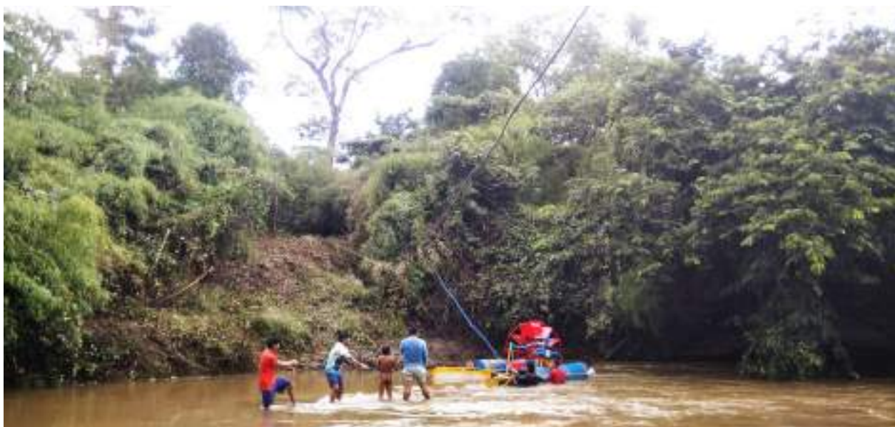
Imagem 99 (acima): oficina e instalação da balsa com bomba e roda d'água. Note que no canal do rio onde se encontra a balsa, a água, nesse momento, está à altura do peito. Aproveitamos um intervalo entre dias de chuva, para proceder com a instalação. 13 de fev. 2024.
