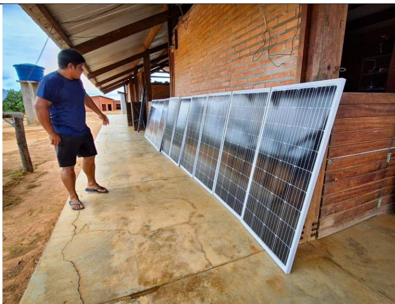
Foto4: Responsável pela instalação da energia solar, Nuki Suya, separando o material para instalação. Polo Wawi, 02/24
