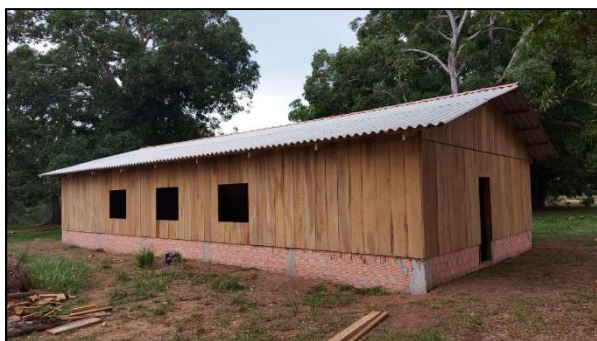
Construção do alojamento – Polo Leonardo
