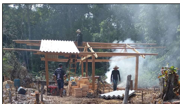
Construção da Base de Vigilância no rio Awaia Missu
