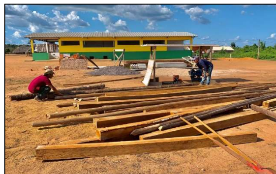
Construção da casa de farinha
