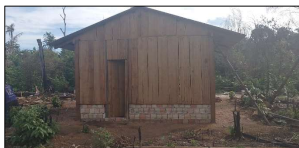
Construção da Base de Vigilância no rio Arraias
