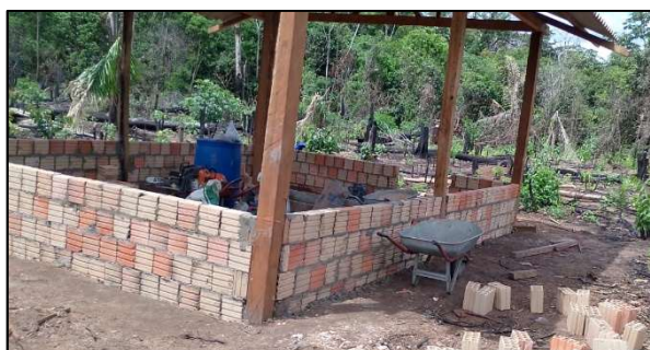
Construção da Base de Vigilância no rio Awaia Missu
