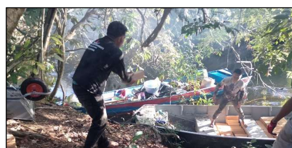
Logística de entrega dos materiais no local de construção da base.
