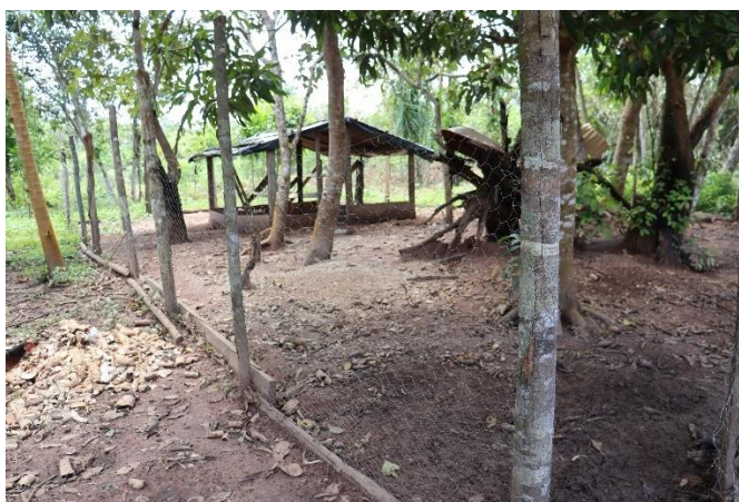
Figura 4. Galinheiro em Wani Wani construído com recursos do projeto. Fotografia: Sol González.
