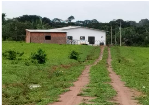
Figura 6 - Frente da fábrica, construção do escritório na frente.
