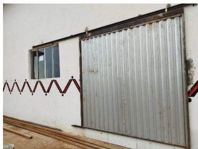
Figura 1 - Instalação da porta da frente;
