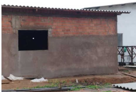
Figura 5 - Construção do escritório/depósito de produto acabado;
