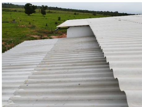
Figura 3 - Telhado do anexo para o secador e telhado da fábrica;
