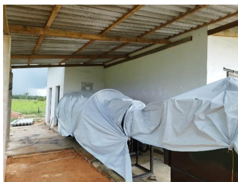
Figura 4 - Construção da parte interna do anexo do Secador;
