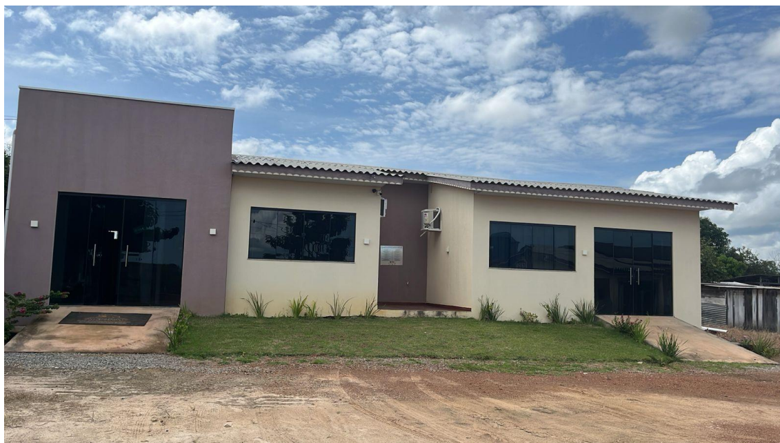
Figura 23. Fachada da sede, com destaque na porta de acesso a recepção e janela da sala de reunião da diretoria (Fonte: Arquivo da Associação AGRIPAC) (13/03/2025).
