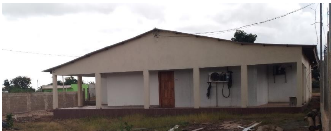
Figura 5. Detalhe externo da Agroindústria, com cobertura da câmara fria, calçadas e proteção externa (Fonte: Arquivo da Associação AGRIPAC) (03/02/2025).
