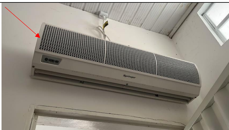
Figura 18. Cortina de ar – R$ 1.050,00 (Fonte: Arquivo da Associação AGRIPAC) (11/03/2025).
