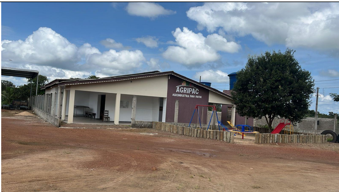
Figura 2. Recepção e área de fachada da agroindústria, com identificação e proteção (Fonte: Arquivo da Associação AGRIPAC) (13/03/2025).
