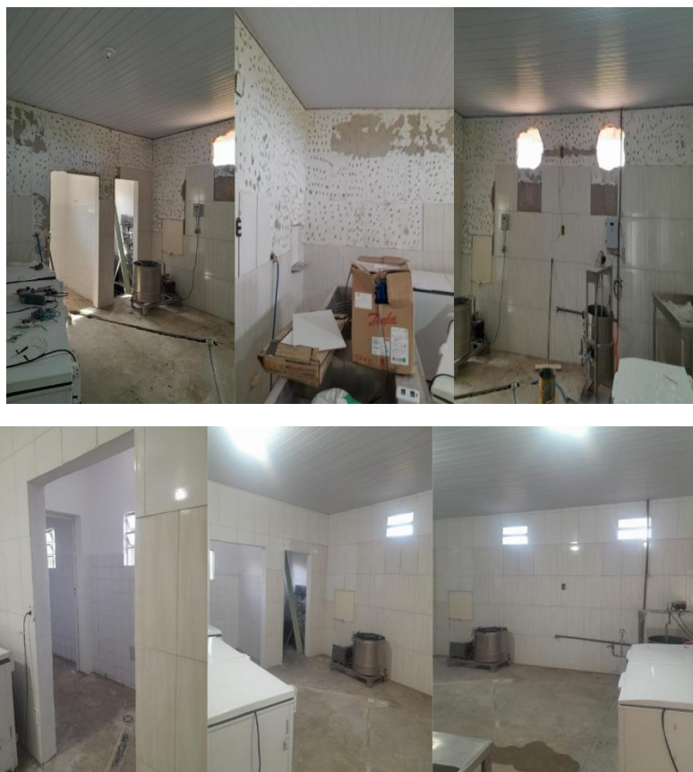
Figura 9: Processo de reforma da cozinha
