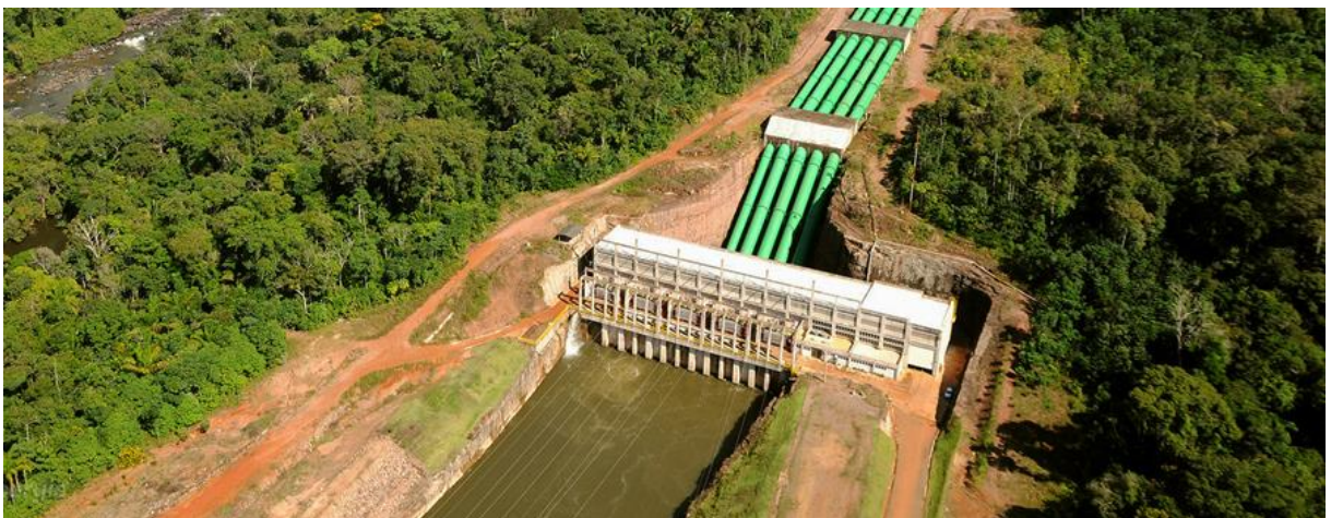
Figura 24: Usina Hidrelétrica de Dardanelos.
