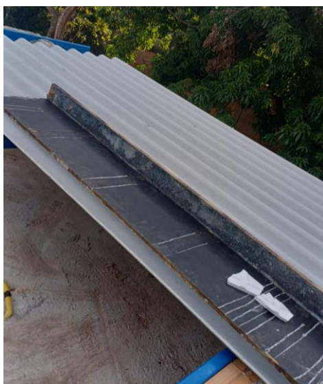
Figura 82. Início de fixação de telhas iniciado em 07 de março de 2024. Autoria: Genésio Alves.
