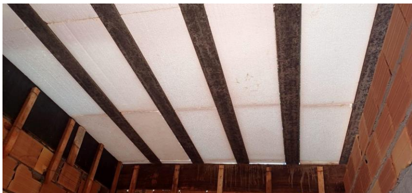
Figura 75. Instalação de laje treliçada com estruturas pré-moldadas. Observação efetuada em acompanhamento de 06 de fevereiro de 2024. Autoria: Genésio Alves da Silva.
