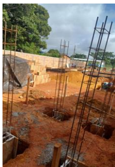
Figura 67. A). Início do levantamento de paredes da Casa de Sementes de Porto Alegre do Norte. B). Instalação de colunas para a alocação da caixa d'água da obra em Porto Alegre do Norte – MT. Registros realizados em 10 de janeiro de 2024. Autoria: Genésio Alves da Silva.
