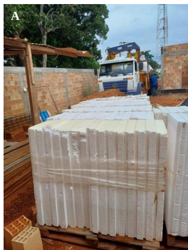
Figura 73. Recepção de materiais para início da construção da laje da obra. A). Isopor para compor laje. B). Vigotas pré-moldadas de concreto para instalação de laje. Do dia 23 de janeiro de 2024. Autoria: Genésio Alves da Silva.
