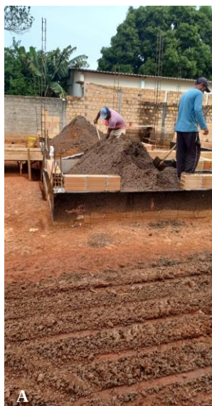
Figura 68. A). Preenchimento de cômodos para aterramento do piso da construção. B). Instalação de estrutura para construção de rampa como parte do projeto Casa de Sementes em Porto Alegre do Norte – MT, com evidência em 11 de janeiro de 2024. Autoria: Genésio Alves da Silva.
