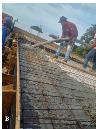
Figura 78. A). Vista superior da obra com armação preparada para concretagem. B). Início do processo de concretagem. Registros de 17 de fevereiro de 2024. Autoria: Genésio Alves da Silva.
