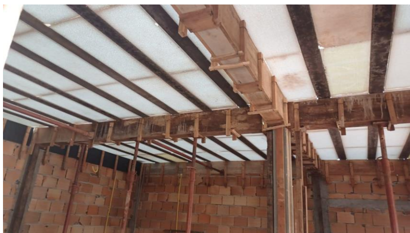
Figura 76. Registro interno da obra após a instalação das placas e preenchimento da laje, efetuado em 08 de janeiro de 2024. Autoria: Genésio Alves da Silva.
