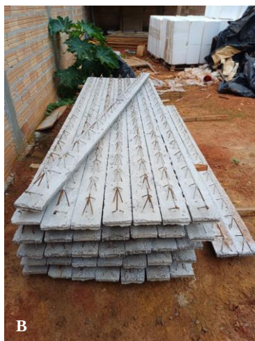
Figura 73. Recepção de materiais para início da construção da laje da obra. A). Isopor para compor laje. B). Vigotas pré-moldadas de concreto para instalação de laje. Do dia 23 de janeiro de 2024. Autoria: Genésio Alves da Silva.
