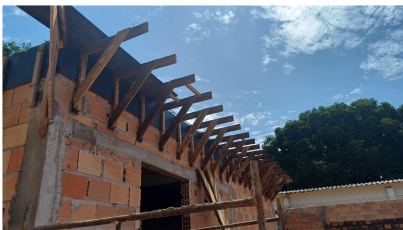
Figura 77. Registro da parte externa da obra relativo a concretagem das bases do telhado em 08 de fevereiro de 2024. Autoria: Genésio Alves da Silva.
