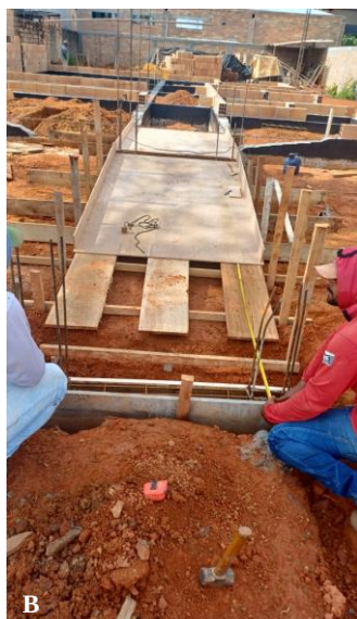
Figura 68. A). Preenchimento de cômodos para aterramento do piso da construção. B). Instalação de estrutura para construção de rampa como parte do projeto Casa de Sementes em Porto Alegre do Norte – MT, com evidência em 11 de janeiro de 2024. Autoria: Genésio Alves da Silva.
