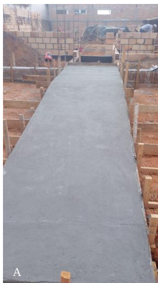
Figura 70 A). Concretagem de armação para consolidação da rampa de acesso a Casa de Sementes. B). Desenvolvimento do levantamento de paredes laterais da obra, em de Porto Alegre do Norte-MT. Registros realizados em 12 de janeiro de 2024. Autoria: Genésio Alves da Silva.
