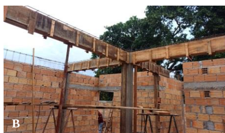
Figura 74. Etapas de prévias para implementação de estruturas para planejamento da laje da obra. A). Armação para concreto armado de sustentação da laje em 23 de janeiro de 2024. B). Implementação de colunas e estruturas de sustentação da laje da parte interna, registrada em 26 de janeiro de 2024. Autoria: Genésio Alves da Silva.
