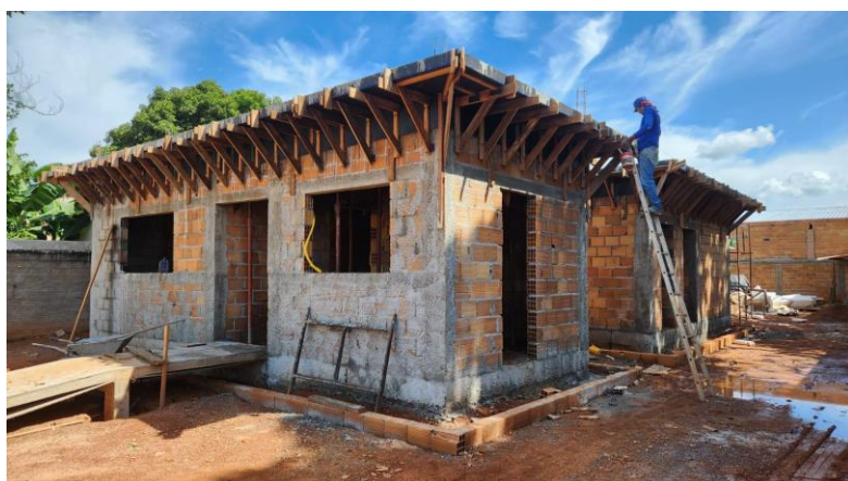
Figura 79. Vista externa da obra em andamento em registro mais recente na data de 17 de fevereiro de 2024. Autoria: Genésio Alves da Silva.
