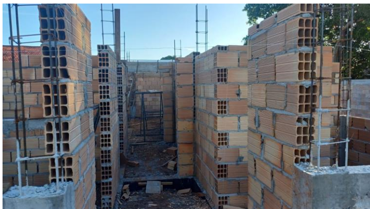
Figura 72. Paredes internas da obra observadas por meio de acompanhamento em 17 de janeiro de 2024. Autoria: Genésio Alves da Silva.
