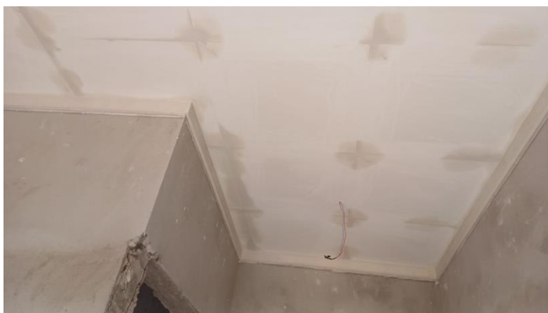
Figura 80. Parte interna com acabamento de gesso e reboco já encaminhados efetuado em 07 de março de 2023. Autoria: Genésio Alves.
