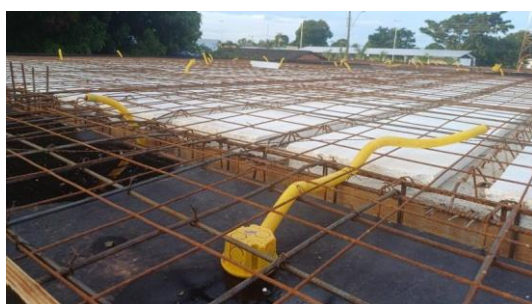
Figura 78. A). Vista superior da obra com armação preparada para concretagem. B). Início do processo de concretagem. Registros de 17 de fevereiro de 2024. Autoria: Genésio Alves da Silva.
