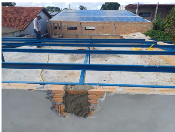
Figura 81. Instalação da estrutura de telhado iniciada em 07 de março de 2024. Autoria: Genésio Alves.
