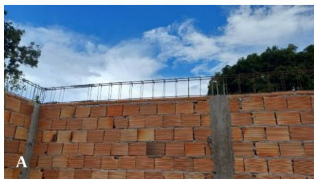
Figura 74. Etapas de prévias para implementação de estruturas para planejamento da laje da obra. A). Armação para concreto armado de sustentação da laje em 23 de janeiro de 2024. B). Implementação de colunas e estruturas de sustentação da laje da parte interna, registrada em 26 de janeiro de 2024. Autoria: Genésio Alves da Silva.
