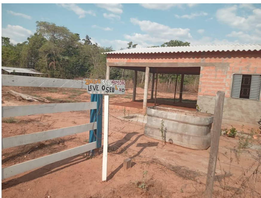
Imagem 11: Construção da Sede da APPRBR. Foto: Mariozan Ferreira.
