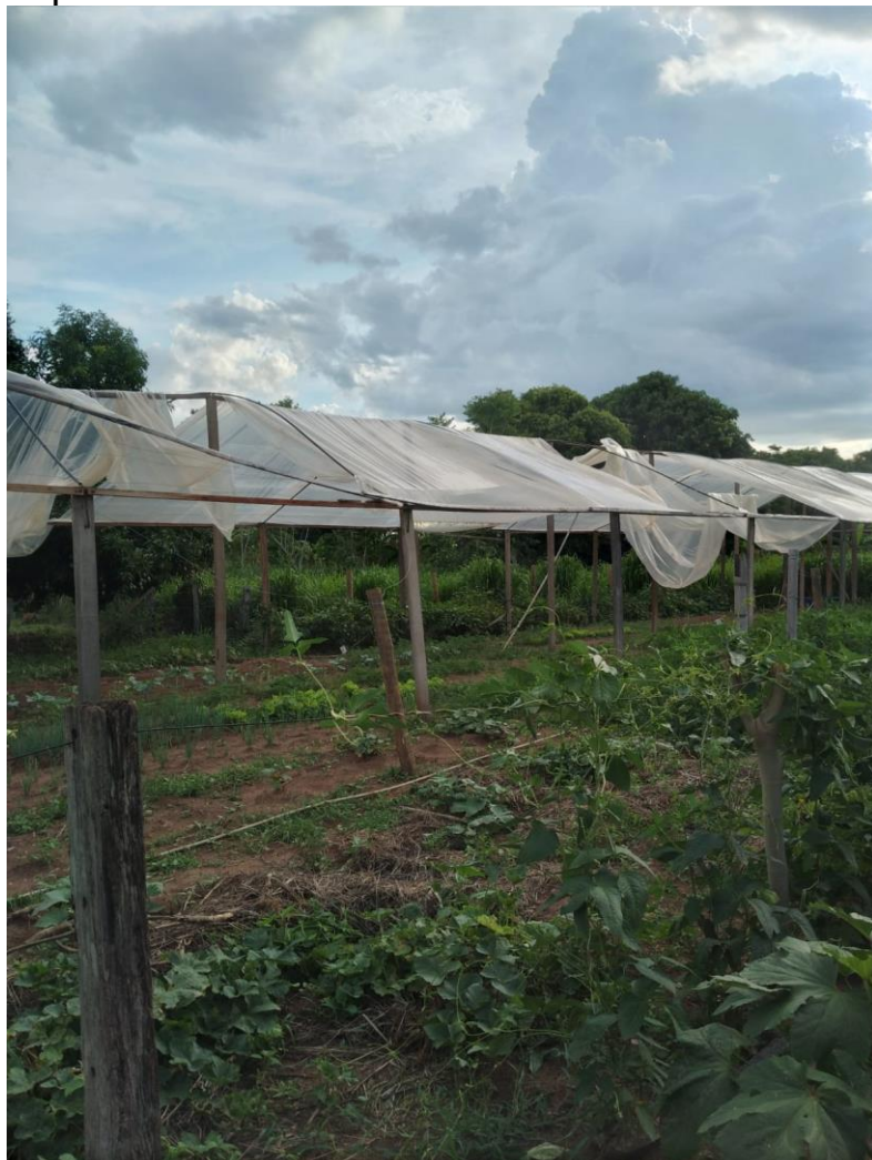
Figura 10: Estufa impactada por tempestades locais
