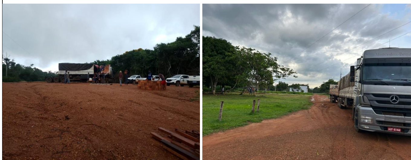
Figura 02: Descarregamento de materiais de construção na Aldeia Tatui- Associação Kawaiwete em Juara-MT dia 15/11/2024:
