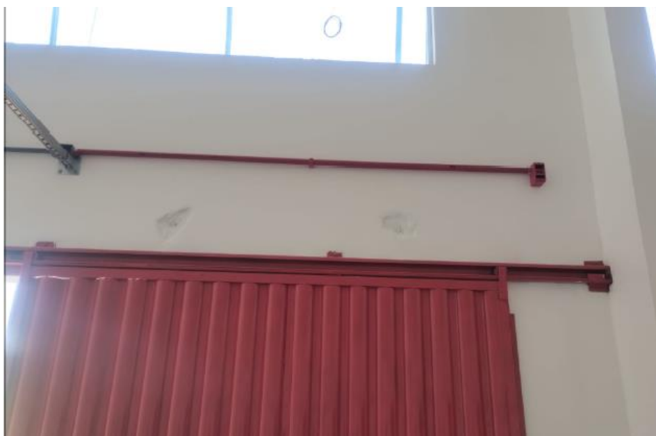
Figura 10: Agroindústria reformada (combate a incêndios)
