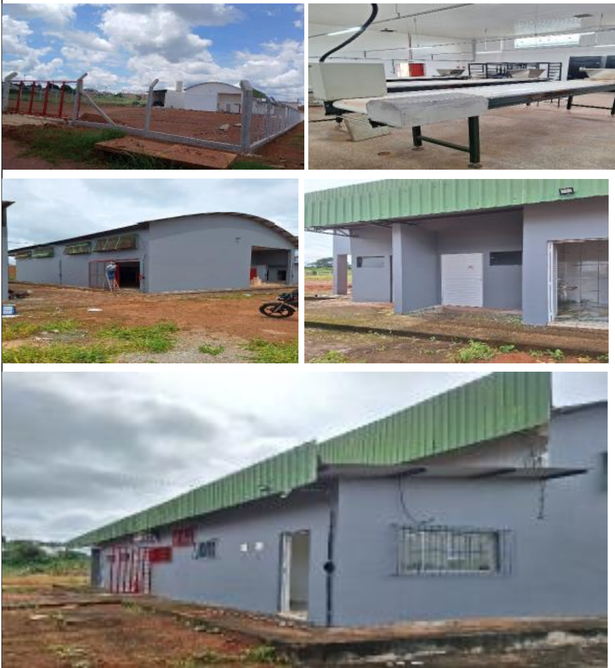
Figura 5: Agroindústria reformada (Pintura, alambrado)
