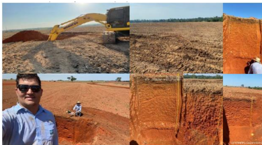
Figura 15: Abertura das trincheiras para caracterizar o solo da área experimental UD, município de Juara (MT).
