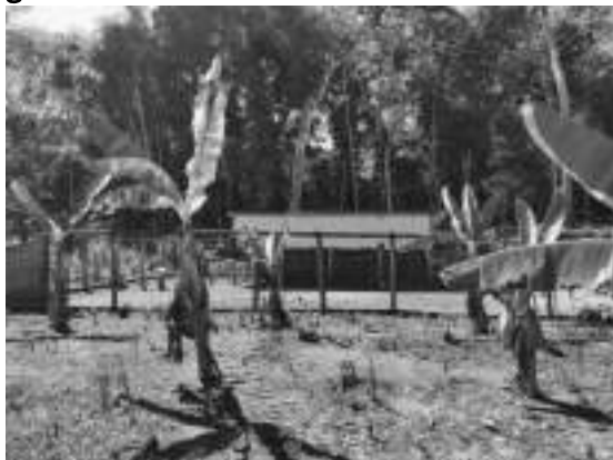
Aldeia Boa Esperança – Trumai 1. Construção de galinheiro
