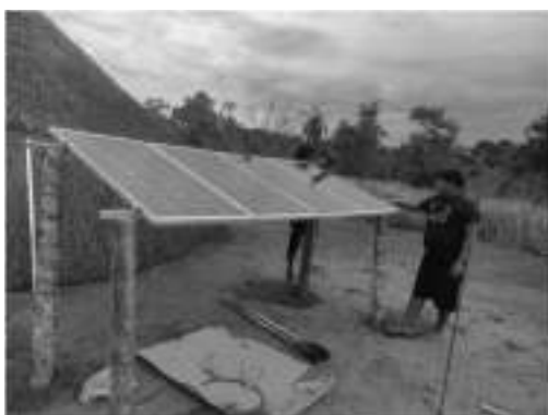
Matipu - Aldeia Buritizal 3 Instalação o sistema de energia Fotovoltaico.
