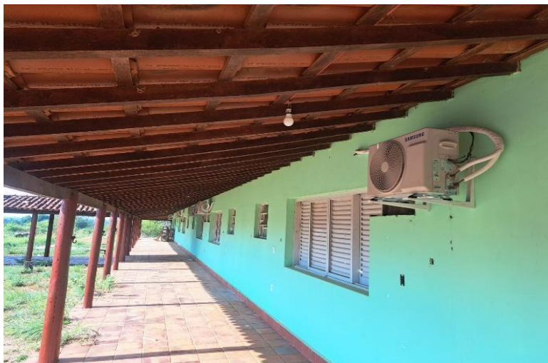
Figura 5: Compra de equipamentos ar-condicionado para os alojamentos.
