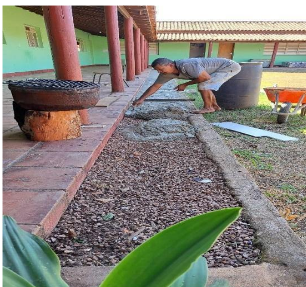
Figura 3: Realização da reforma, calçada em reforma.
