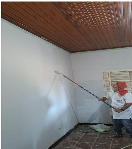
Figura 2: Realização da reforma, alojamento em reforma.
