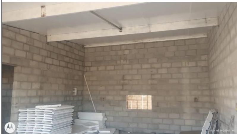
Figura 21- 23: construção das fossas e cobertura do telhado da agroindústria. Etapa 2.
