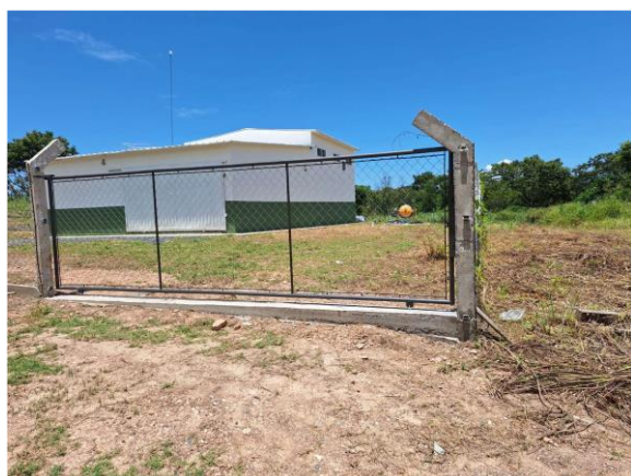
Figura 29: Cerca e Portão Instalados. Etapa 3.
