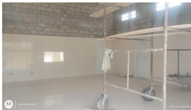
Figura 30: Colocação de cerâmicas e azulejos. Etapa 3.
