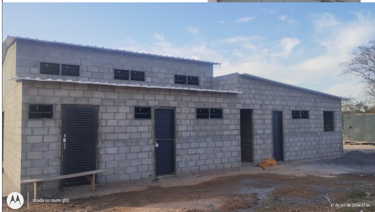
Figura 24- 26: Instalações elétricas, hidráulicas, portas e janelas. Etapa 2.
