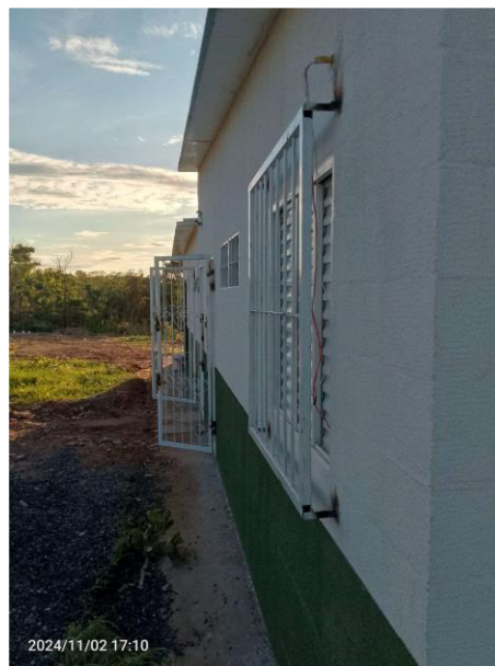
Figura 28: Grades nas portas e janelas. Etapa 3.
