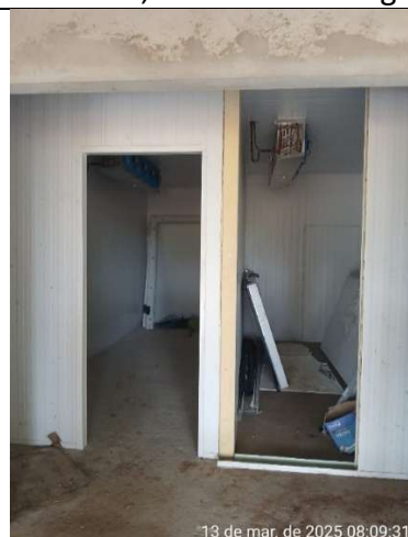
Foto 14 e 15 – Câmara fria montada
