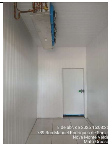
Foto 13 – Câmara fria finalizada
