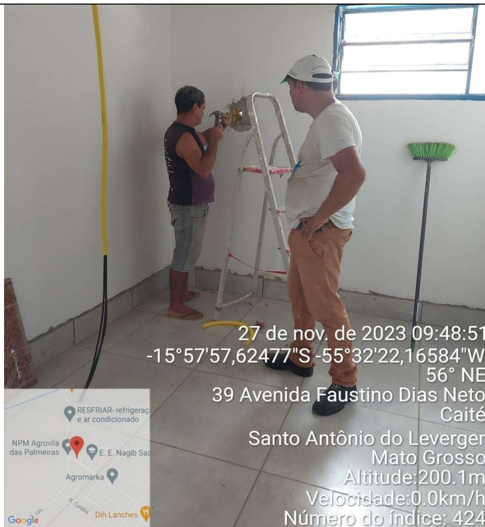
Figura 14: Foto de Daniel fazendo acompanhamento da reforma na sede da cooperativa Coopamsal.
