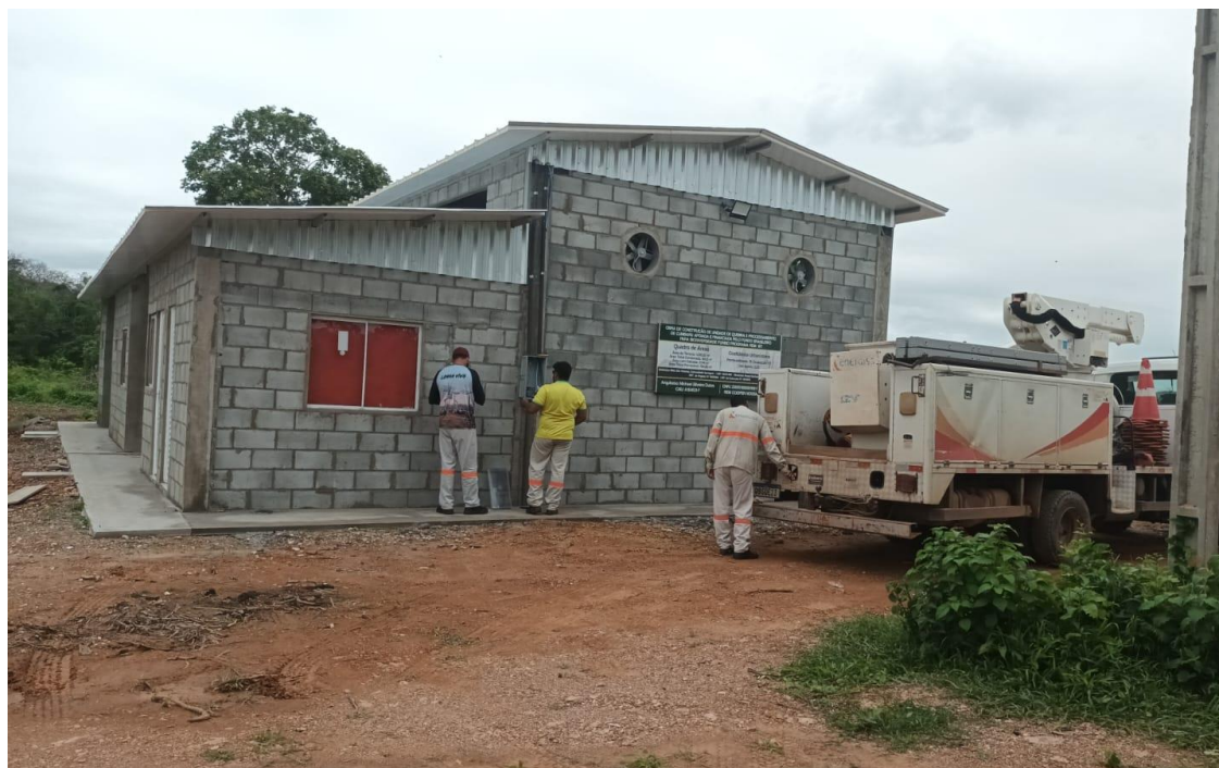
Figura 10: Agroindústria para beneficiamento de Cumbaru na Comunidade Serragem em Nossa Senhora do Livramento-MT.
