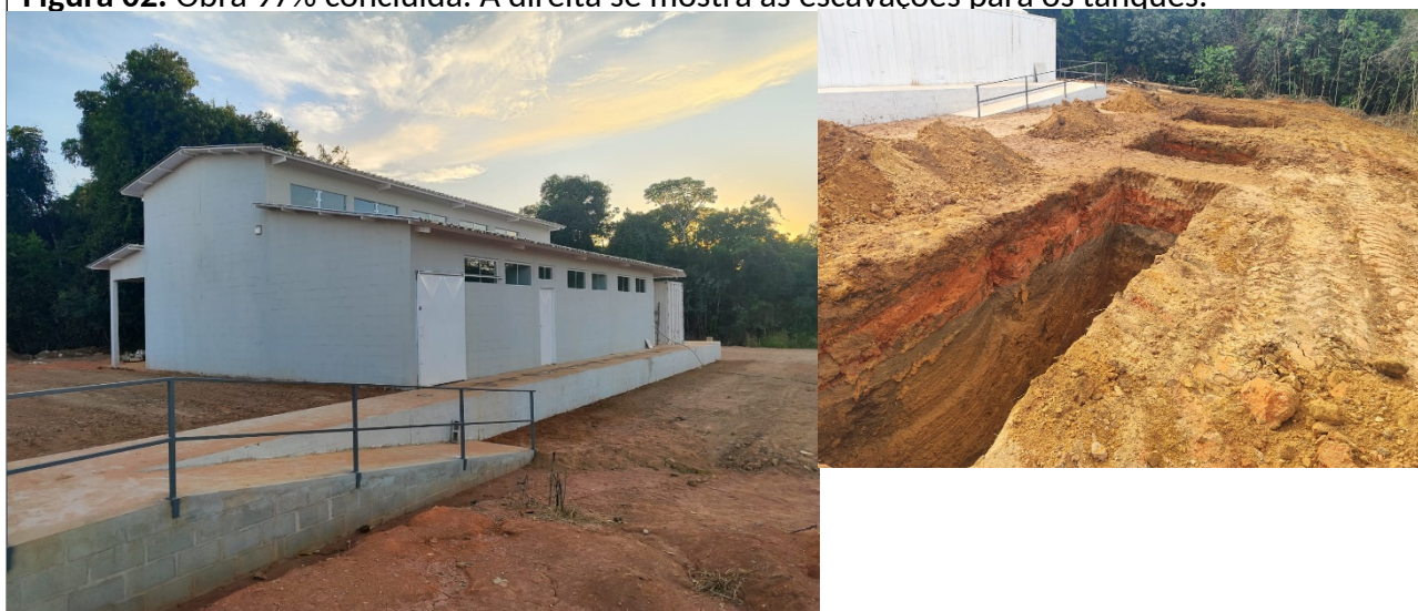
Figura 02: Obra 97% concluída. A direita se mostra as escavações para os tanques.
