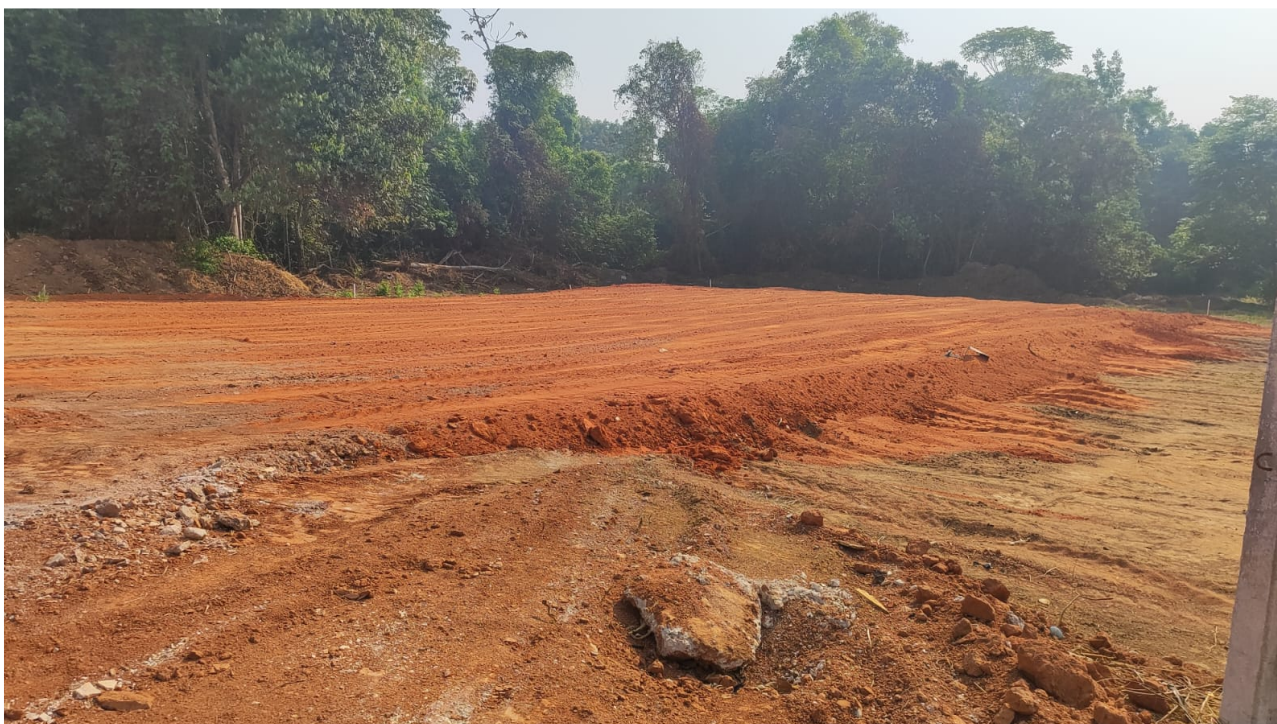
Figura 01: Terraplanagem para a obra.
